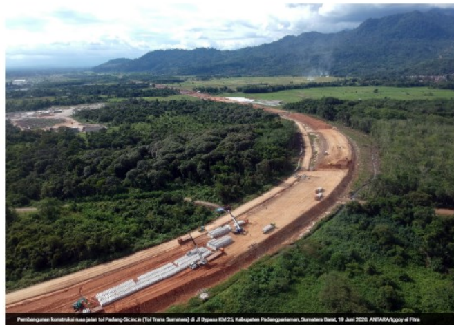
Pembangunan koridor ruas jalan tol Pematang Siantar (Tol Trans Sumatera) di Jl. Pematang KM 25, Kabupaten Pematangsiantar, Sumatera Utara, 19 Juni 2020. ANTARA/Agung di Fita
